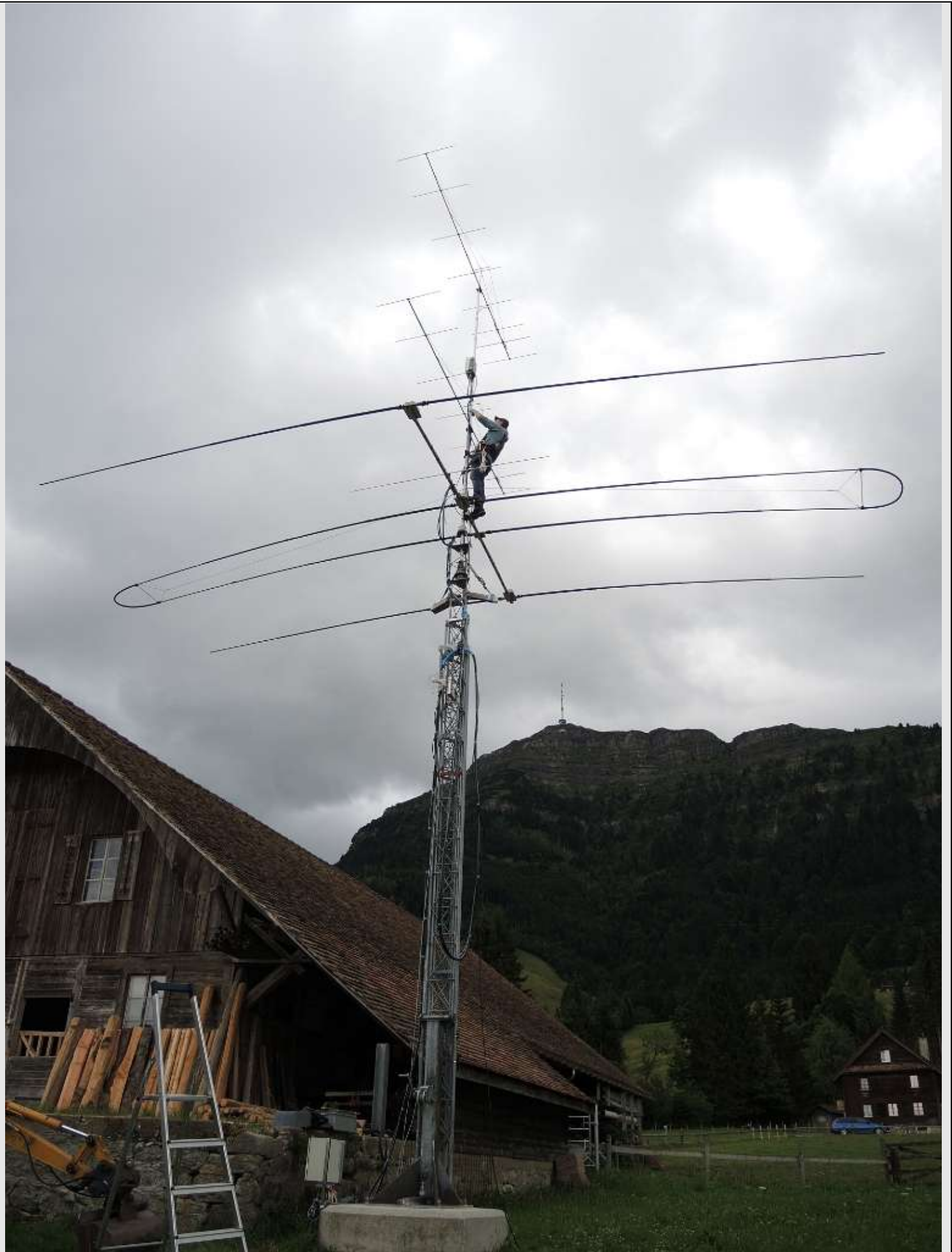
Fredl HB9TTY in schwindelnder Höhe bei den zwei mal 8 Element Yagis.
