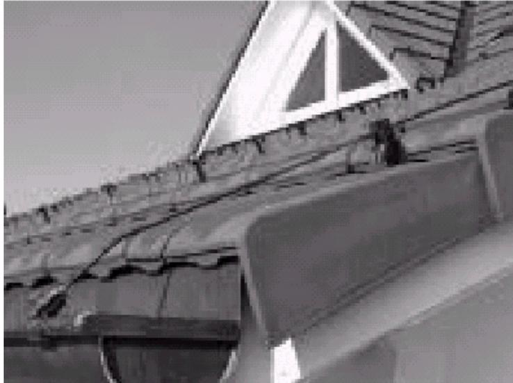
*Bild 1: Der äussere Blitzschutz besteht aus Fangleitungen auf dem Gebäudedach...*
