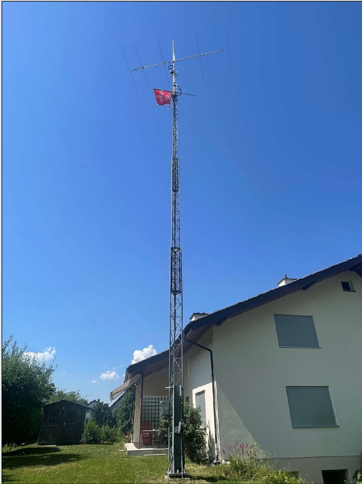
HB9TTY, JN37XG (AG) – 5ele für 50 MHz
